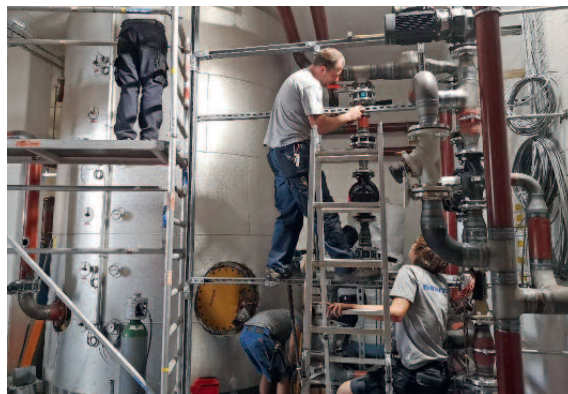
HZ Blegi im Bau
